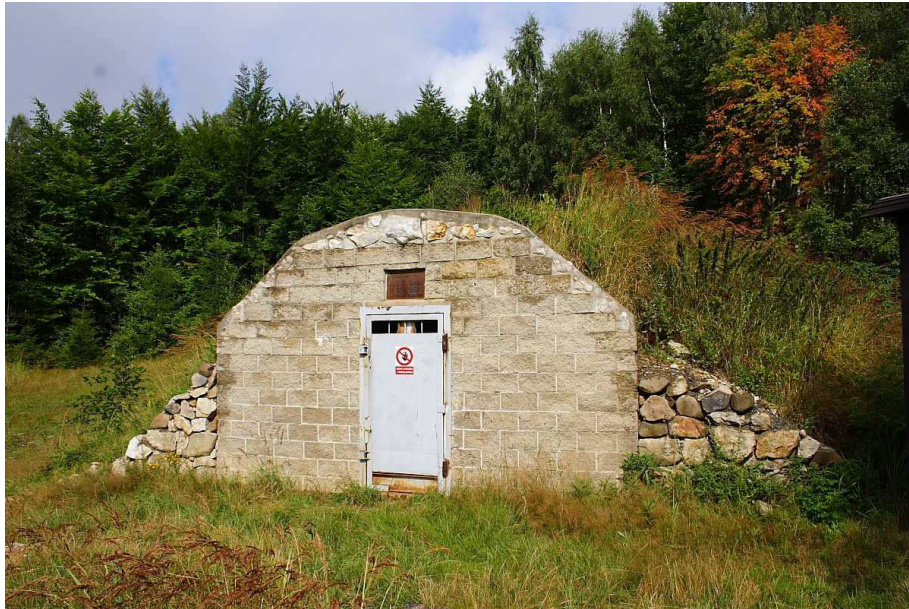
Haupteingang zum Stollen Nr.4
